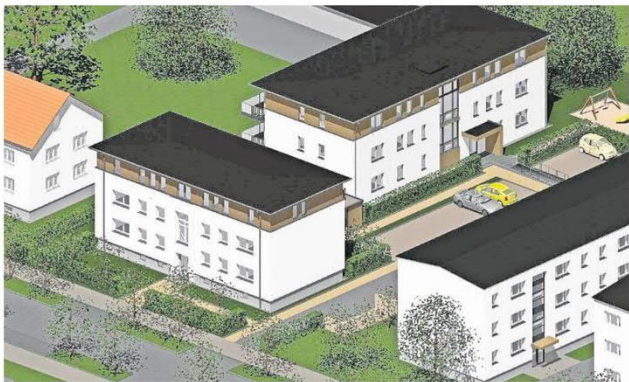
So soll es in der Breitscheid-Straße in Kühlungsborn aussehen, wenn der Bau abgeschlossen ist. Das Bestandsgebäude wurde um ein Geschoss aufgestockt, dahinter ist ein Neubau entstanden. GRAFIK: NOVEG
